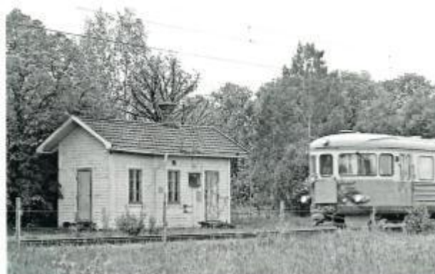
Kungsryds hållplats på Karlsborgsbanan. 1986, när detta foto togs, var hållplatsen fortfarande i originalskick. Foto Björn Malmer
